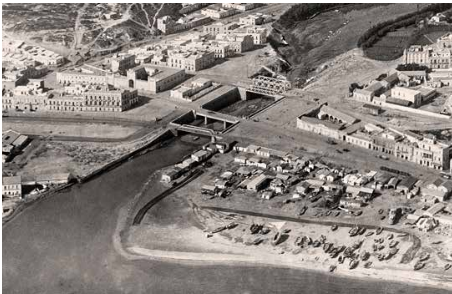
Foto área de los puentes sobre río Oro.
