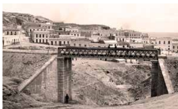
Puente metálico sobre el barranco de Cabrerizas 1905
