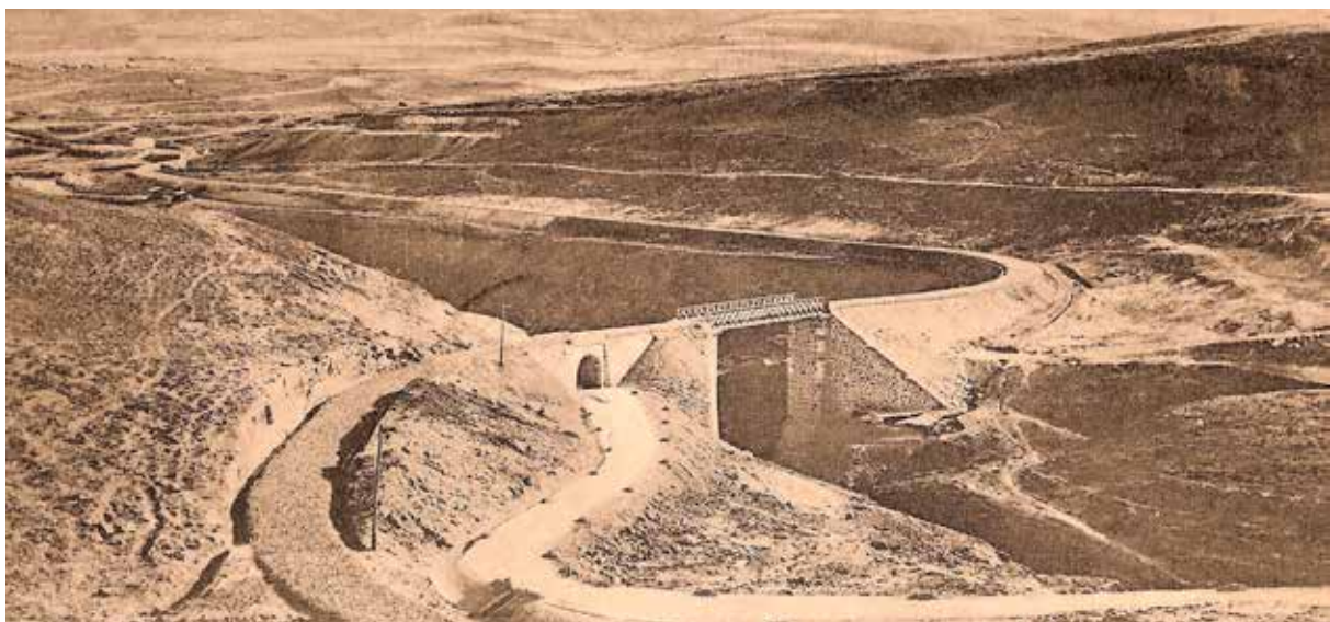
Foto puente metálico sobre el barranco Horcas Colorados. 1905.
