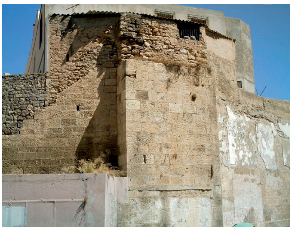
Estribo del puente metálico en el barranco de Cabrerizas.
