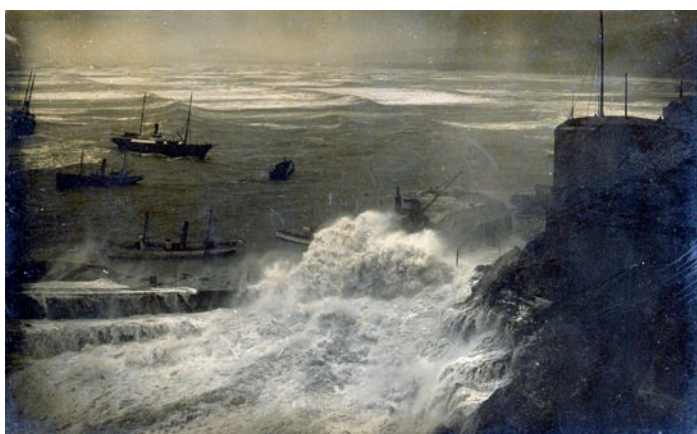
Efectos del oleaje en el arranque del Dique Nordeste. Foto: Archivo Cronista Oficial de la Ciudad. Marzo 1914.
