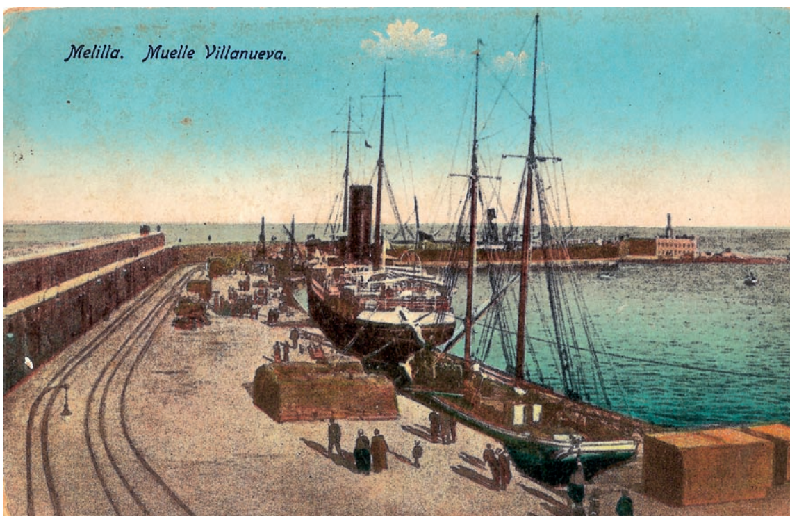
Vista del puerto una vez acometidas las obras de reparación 24 . Postal de la época. Archivo Juan Díez. 1918-1920
