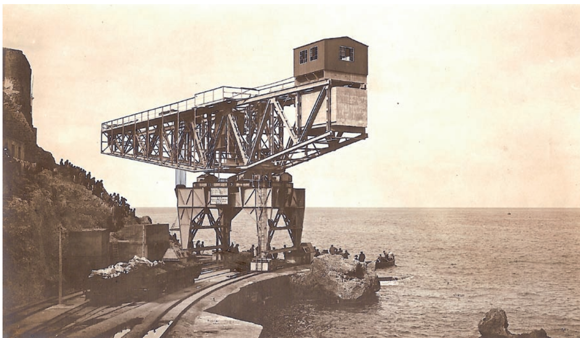
La Grúa Titán en el arranque del Dique Nordeste, en el inicio de las obras del primer ramal. Foto Archivo Juan Diez. 1907.
