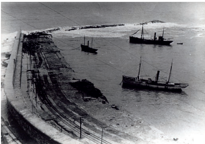
Una vez amainó el temporal puede observarse en la foto el daño ocasionado en el puerto. Foto: Archivo Autoridad Portuaria. Marzo 1914.
