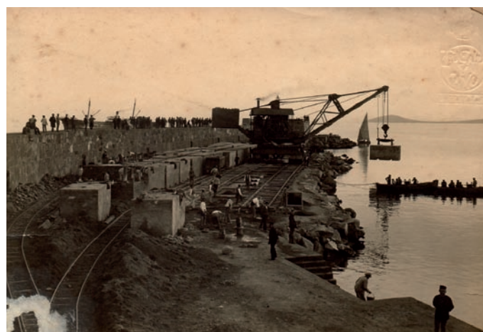
Reconstrucción del segundo ramal del Dique Nordeste y construcción de su muelle. Foto Archivo Autoridad Portuaria. 1916.
