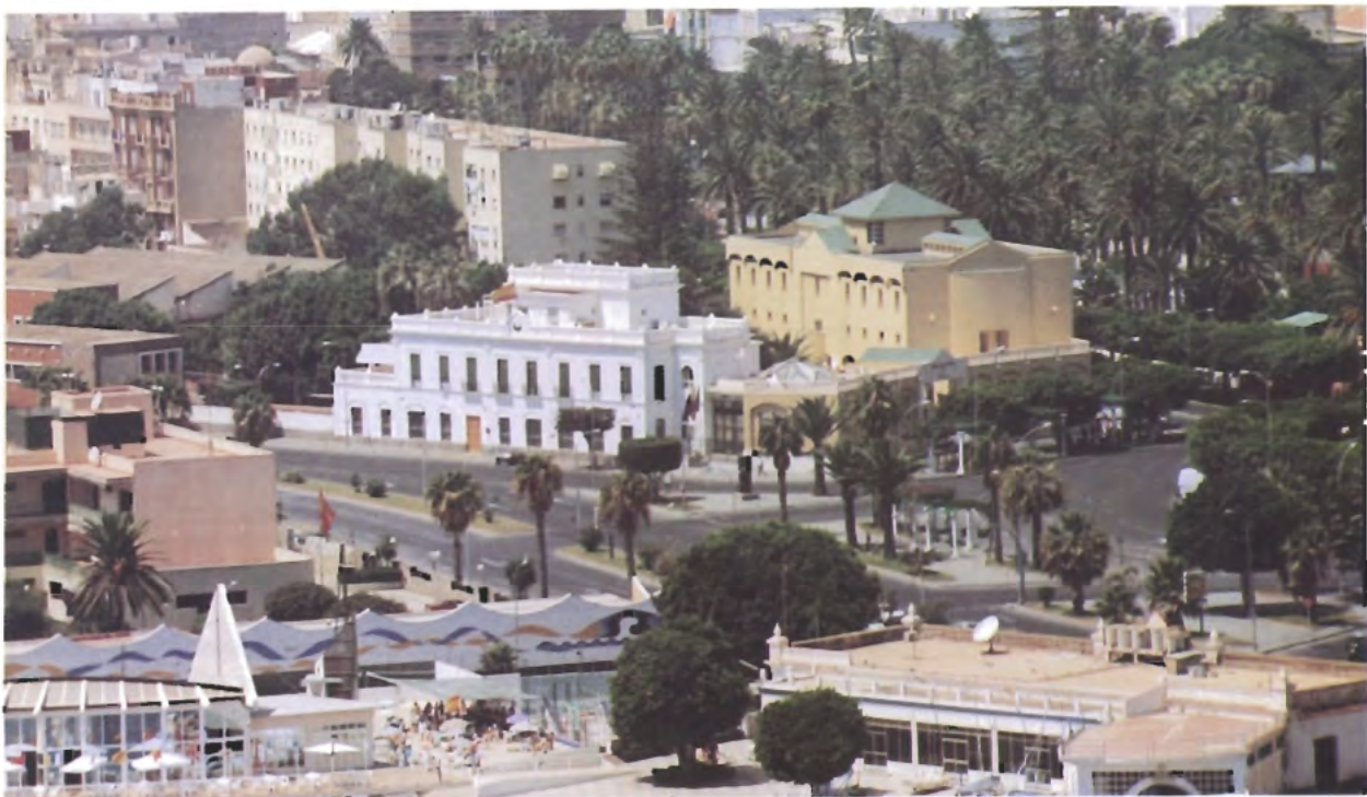
Edificio de la Autoridad Portuaria
