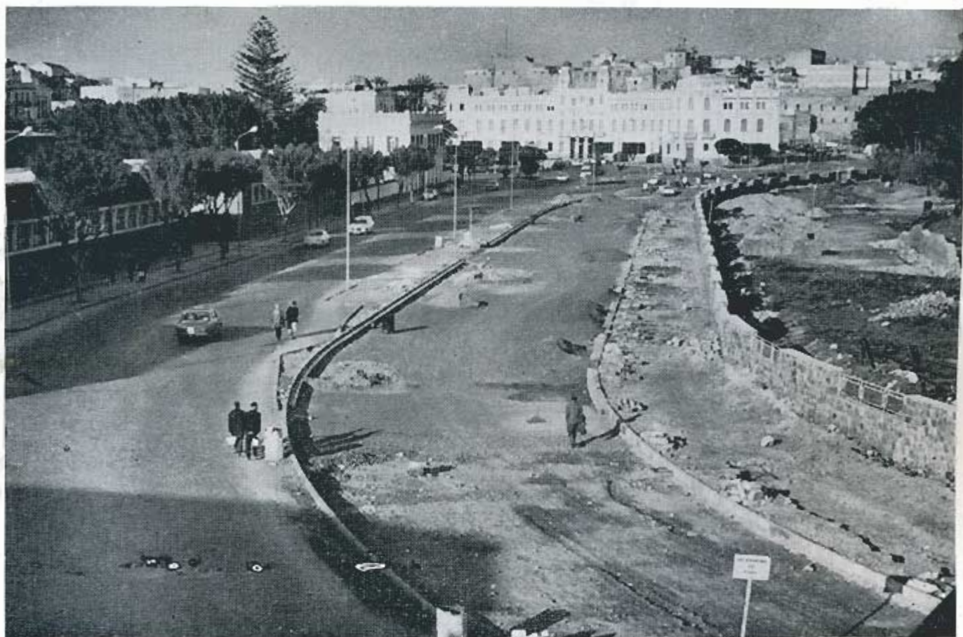
Obra de "Ensanche de la Carretera del Puerto entre la Dársena y el Cargadero de Mineral"
