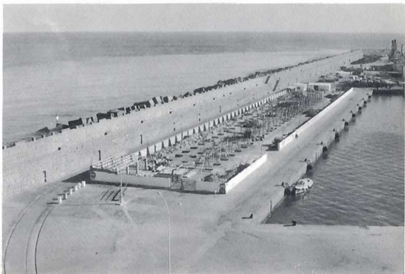
Comienzo de las obras de la Estación Marítima - Noviembre 1968
