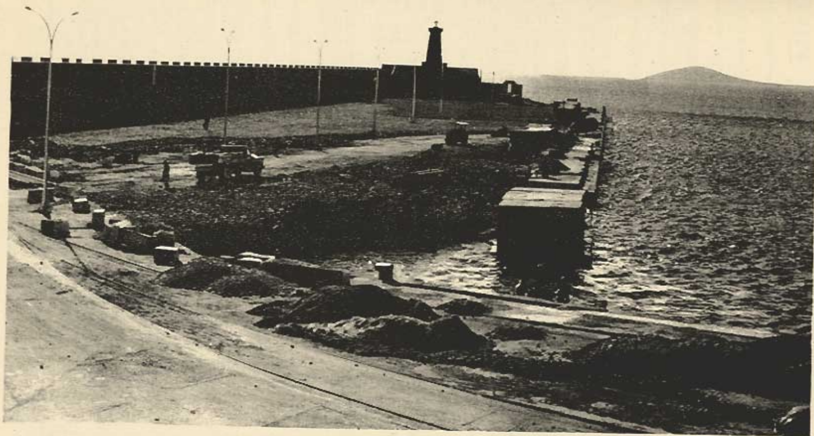
Estado actual de las obras de ensanche de la 3. a alineación del dique Nordeste.
