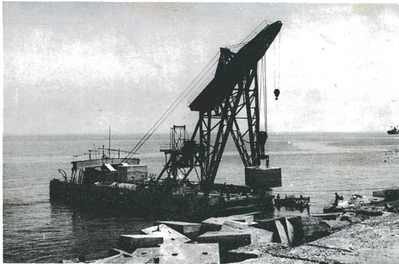
La grúa de 80 T. colocando bloques en la defensa del Dique Nordeste
