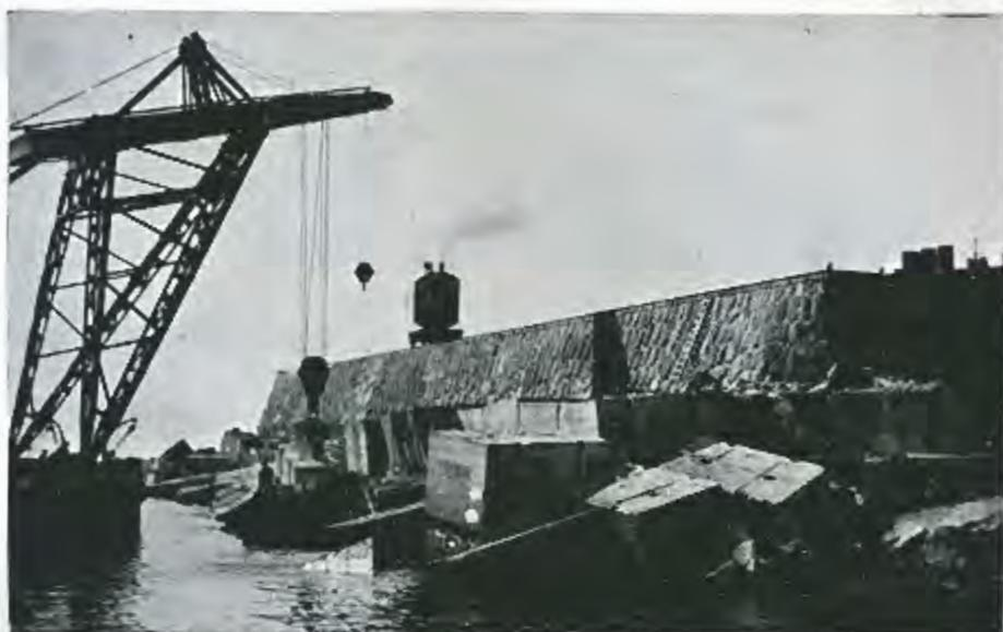
Colocación de bloques de protección en el dique Nordeste
