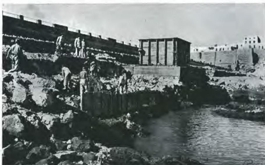
Obras de reparación de la 1.<sup>a</sup> alineación del dique Nordeste
