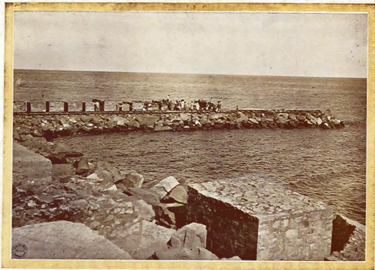
PRIMERA ALINEACIÓN DE LA PROLONGACIÓN DEL DIQUE N. E. (Estado de las obras en 31 de Diciembre de 1922)
