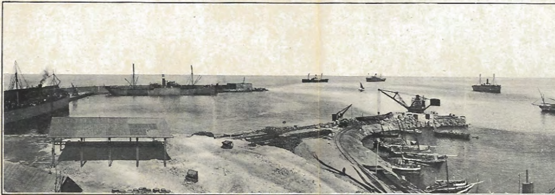
Estado de las obras de los Muelles de ribera al empezars
