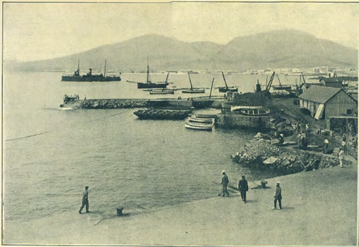
ESTADO DE LAS OBRAS DE LOS MUELLES DE RIBERA EN 14 DE JULIO DE 1917
