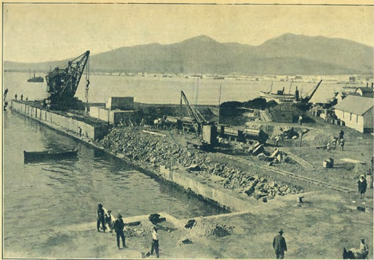
ESTADO DE LAS OBRAS DE LOS MUELLES DE RIBERA EN 30 DE MARZO DE 1918
