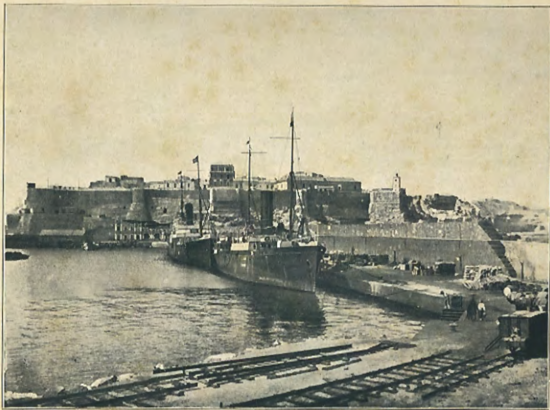
PARTE ATRACABLE DEL DIQUE N. E.
