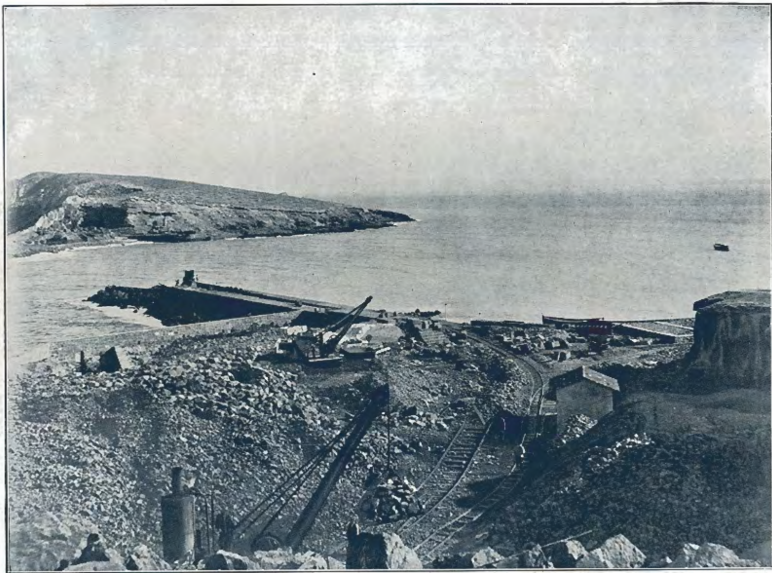
DIQUE DEL N. O. DEL PUERTO DE CHAFARINAS
