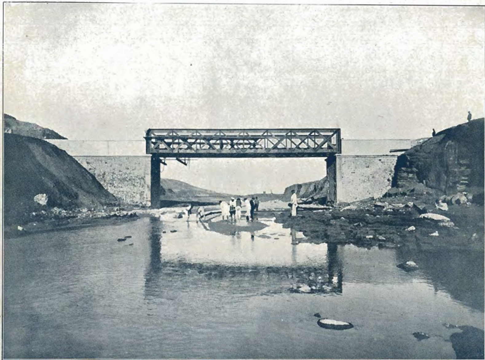
PUENTE SOBRE RÍO ORO DEL FERROCARRIL LÍMITES
