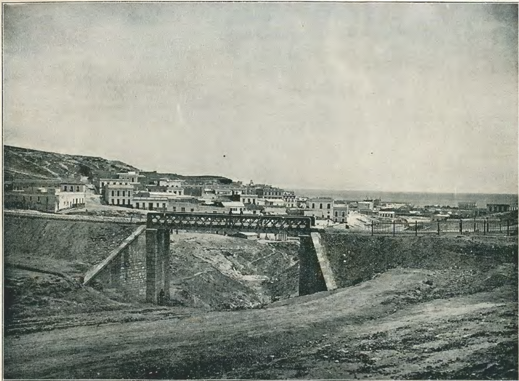
VISTA DEL PUNTE METÁLICO DEL BARRANCO DE CABRERIZAS, EN EL FERROCARRIL DE LAS CANTERAS AL ORIGEN DE ABRIGO.
