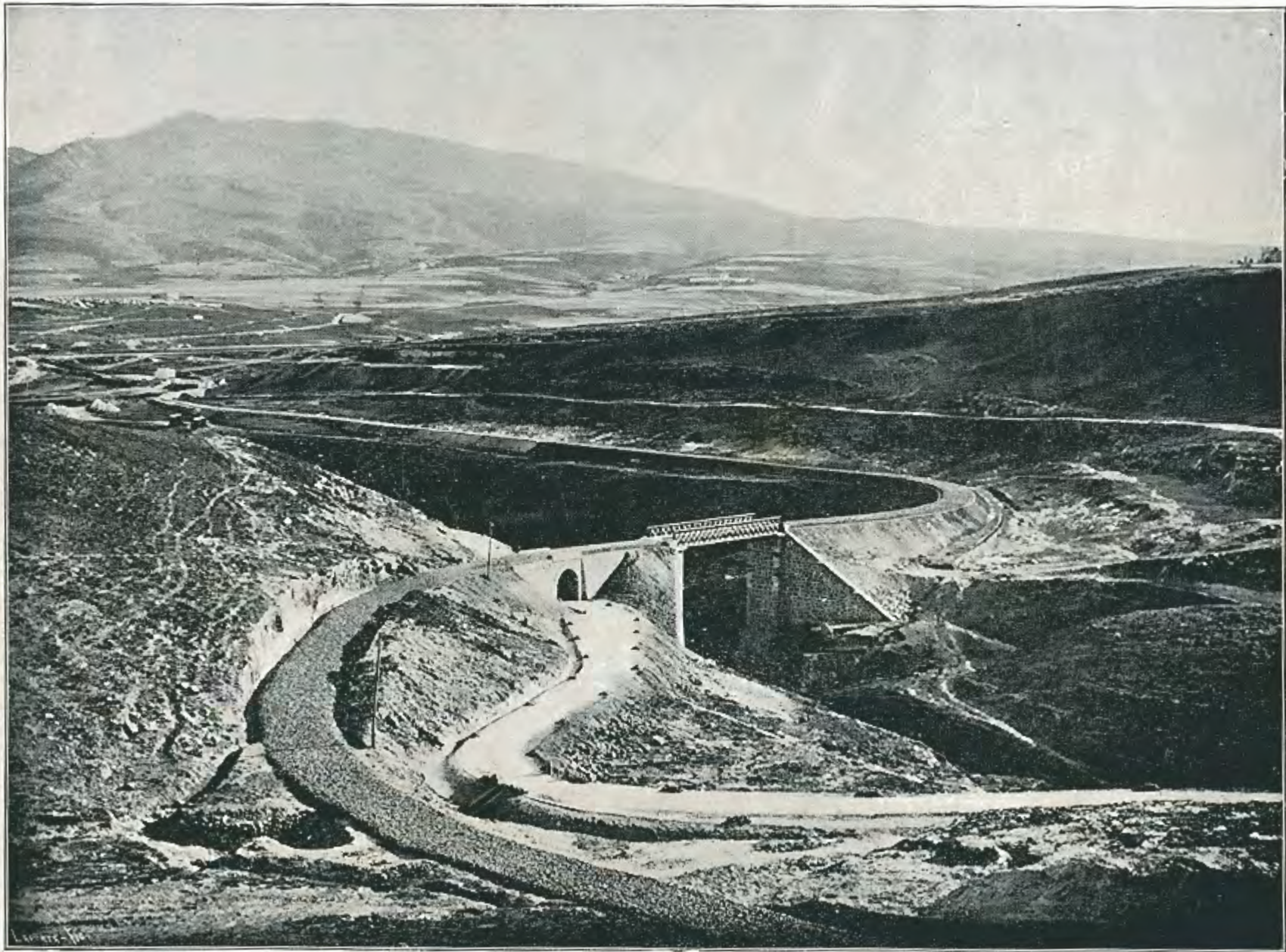
VISTA DEL PUENTE METÁLICO SOBRE EL BARRANCO DE HORCAS COLORADAS Y DEL PASO INFERIOR DEL FERROCARRIL SOBRE LA CARRETERA DEL POLÍGONO A LAS CANTERAS.
