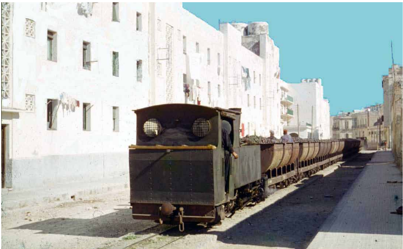
Tren por la calle Álvaro de Bazán
